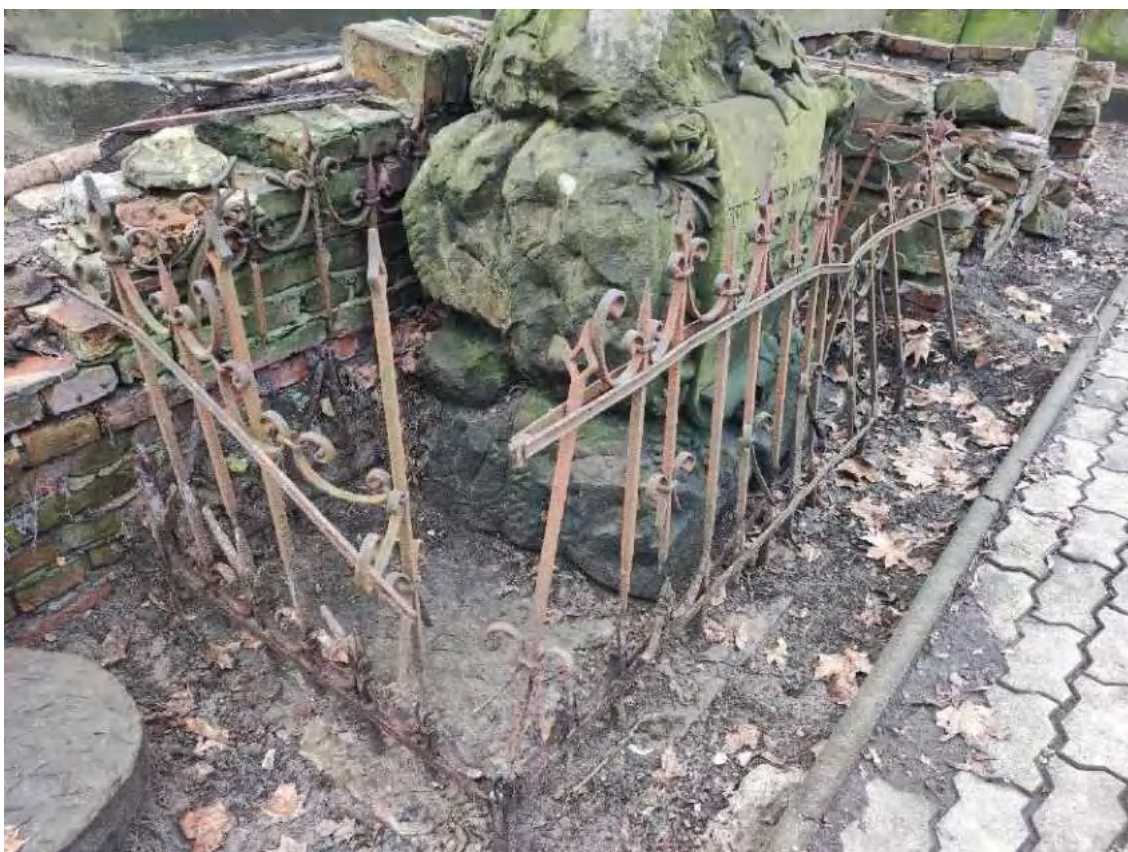
Stan zachowania ogrodzenia i elementów podstawy.
