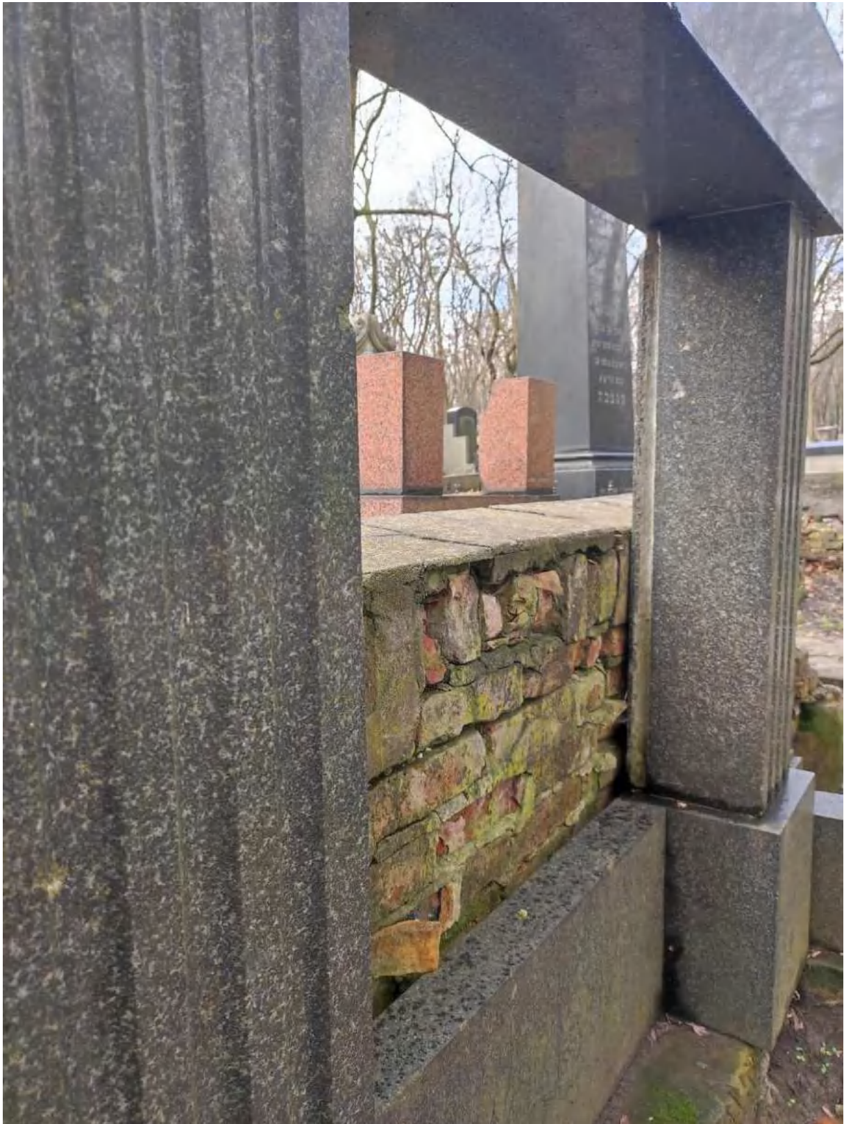
Wzdłuż filaru wyżłobione profile po umocowanej pierwotnie płycie.
