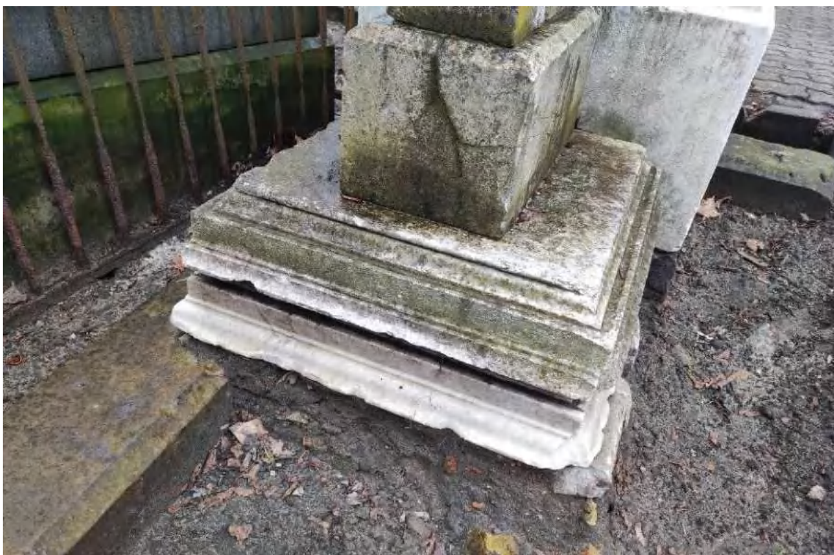
Widoczna zdublowana podstawa świadcząca o wtórnej formie nagrobka.
