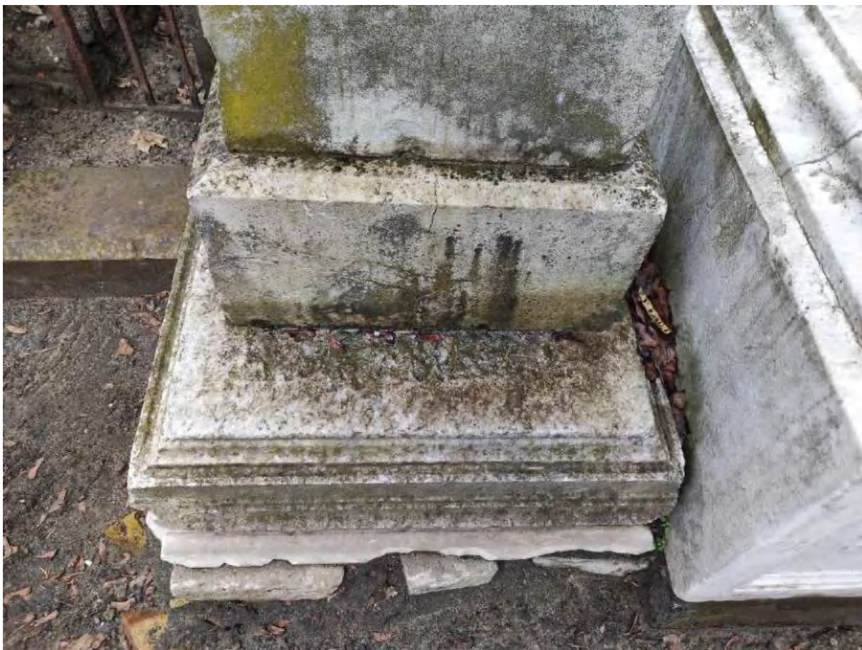
Widoczne fakturowanie w centralnej części płyty podstawy świadczące o wtórnej formie nagrobka.
