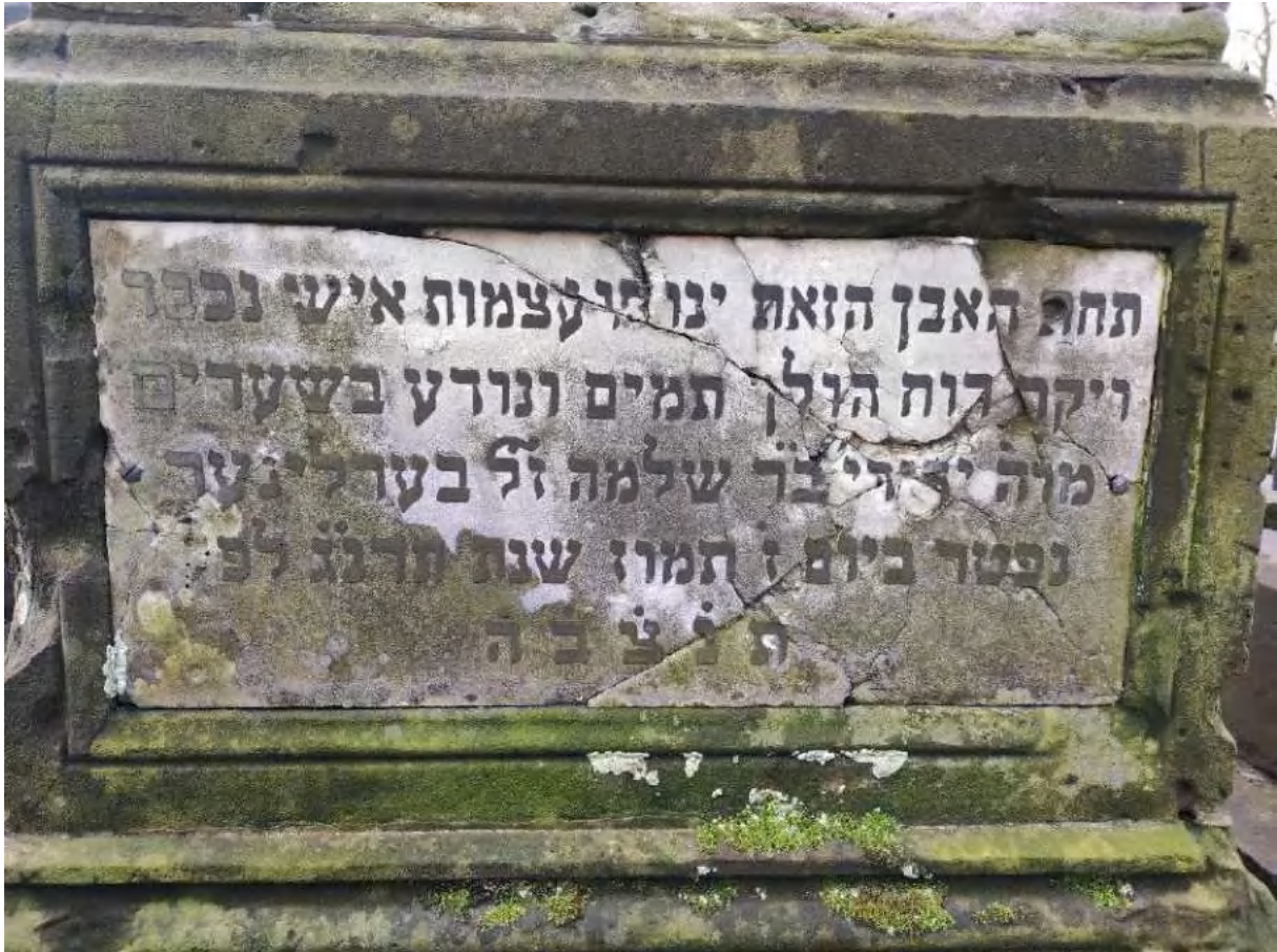
Stan zachowania dolnej płyty inskrypcyjnej.
